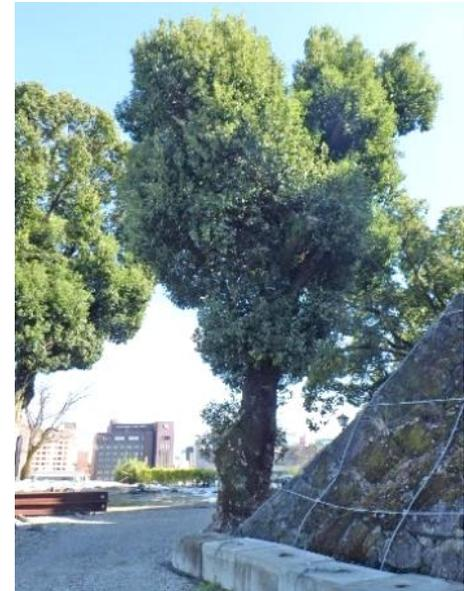
石垣底部に生育し、石垣を押し上げるなど変形させる
