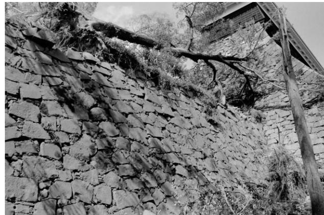
事例4：倒木による東十八間櫓石垣天端石の変状
