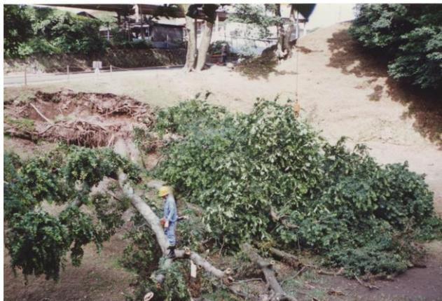
事例3：倒木による法面崩落
