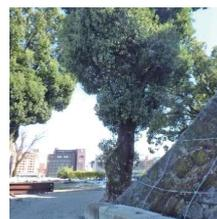
〈石垣底部に生育し、石垣を押し上げるなど石垣を変形させる樹木〉
