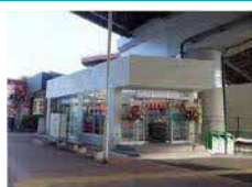
コンビニエンスストア：東名高速道路高架下（横浜市）
