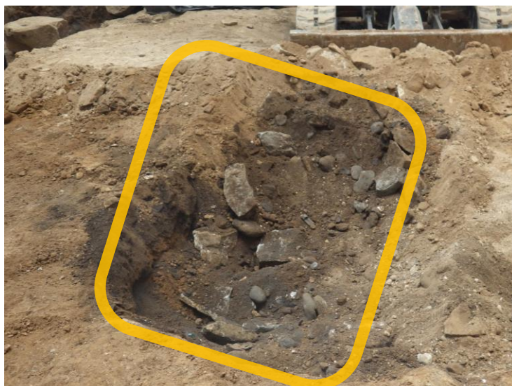
写真1 コンクリート基礎下 根固めの掘削状況 オレンジ枠内：黒色砂と角礫
