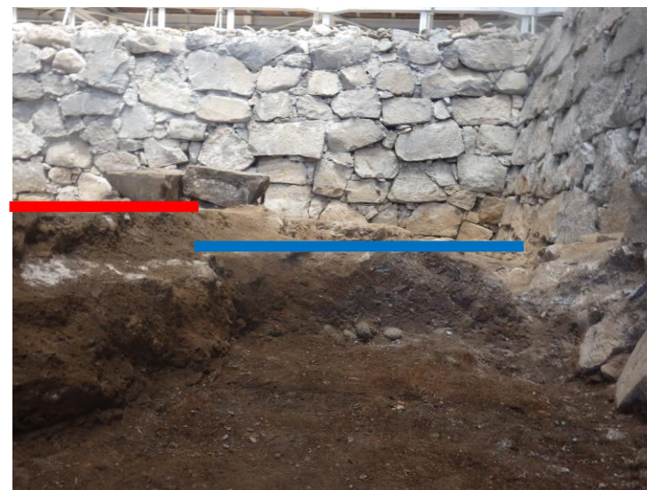
写真1 コンクリート基礎下 根固めの掘削状況 オレンジ枠内：黒色砂と角礫
