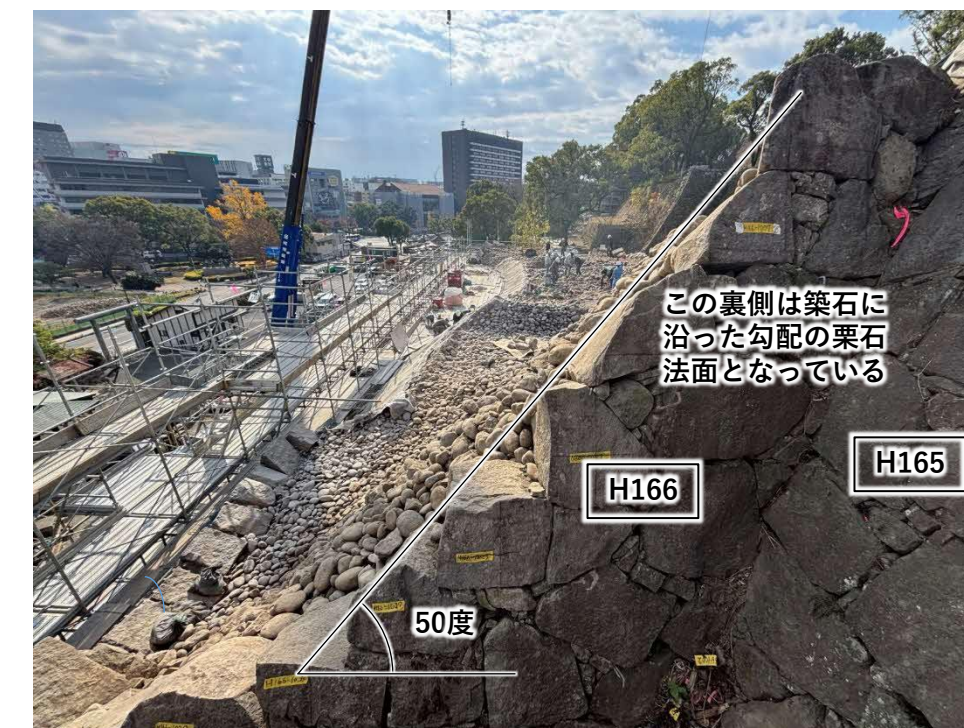
写真3：施工時の現地状況_H166
