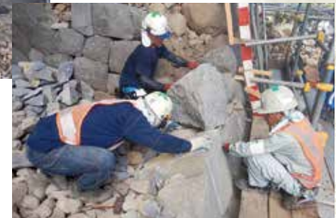
▲大天守北面石垣の積み直し作業
