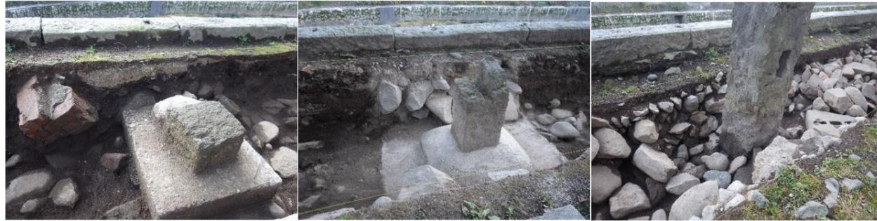
昭和28～30年補強基礎      昭和52年補強基礎      平成3～4年差し替え控柱
