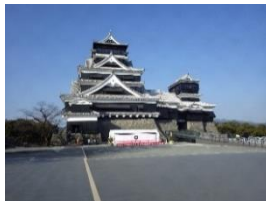
天守閣復旧完了
