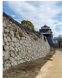
崩落石材回収後(北から)
