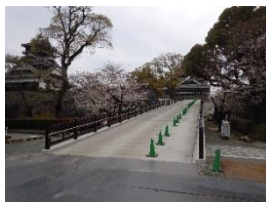
工用スロープ設置
