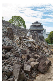
崩落石材回収前(北から)
