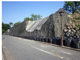
百間石垣安全対策
