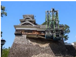
飯田丸五階櫓倒壊防止状況
