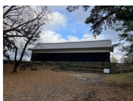
監物櫓復旧完了
