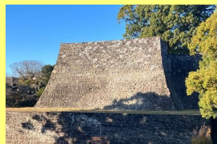
飯田丸五階櫓復旧工事
