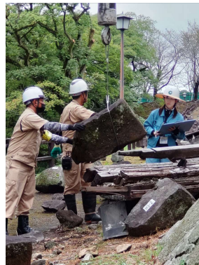
崩落石材回収の様子(南から)
