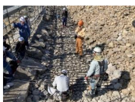
飯田丸五階櫓台石垣工事
