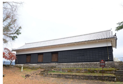
監物櫓 令和5年(2023年)12月 復旧完了
