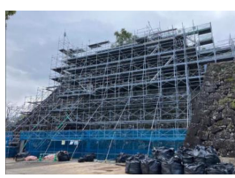
平櫓台石垣復旧工事
