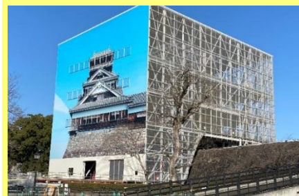
宇土櫓五階櫓解体保存工事
