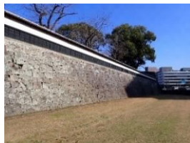
長堀復旧完了
