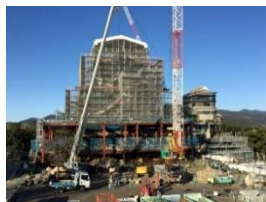
天守閣復旧工事状況
