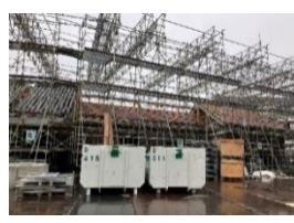
田子櫓ほか南東櫓群復旧工事
