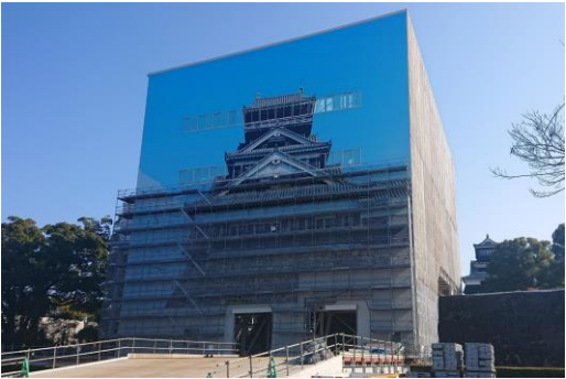
宇土櫓解体保存工事外観
