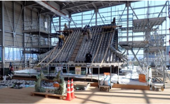
宇土櫓解体保存工事内部の様子
