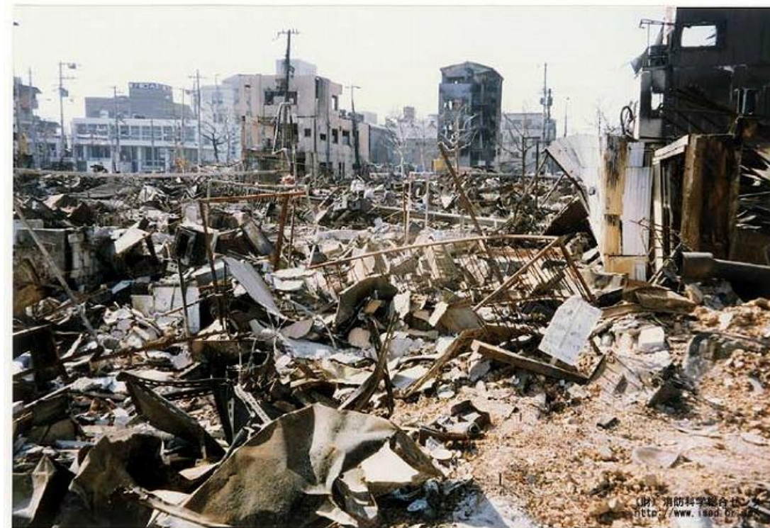
阪神・淡路大震災(兵庫県神戸市長田区)
