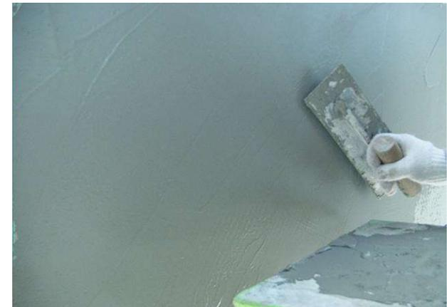
タイル面を含む劣化が進んでいる外壁に、特殊なネットを張り押さえ込み、そこにステンレス製のアンカーピンを打ち込む。その上に左官工事で仕上げていく。表面の仕上げは、ニーズによって塗装、クリア、タイルが選択できる。
