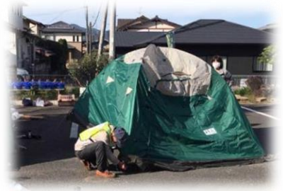
マンホールトイレ設置 (JR熊本シティ実施)
