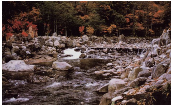
写真2 十和田八幡平国立公園特別地域内鳶川庭園砂防 (伊藤邦衛氏提供)
