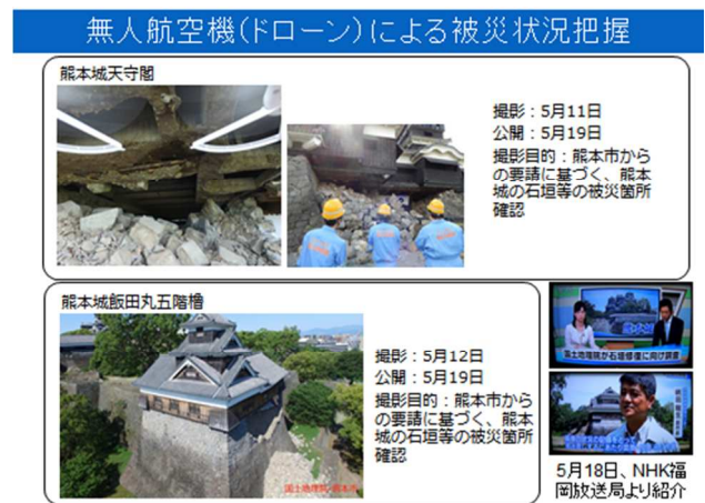
図-9 熊本城におけるドローンによる被災状況把握
