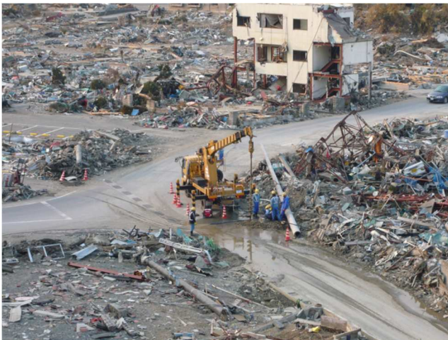
写真-3 電力の応急復旧 (写真提供) 東北電力
