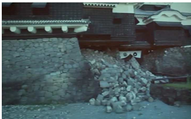
写真-1 ドローンによる被災状況の把握
