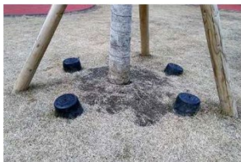
写真Ⅳ-1-21、図Ⅳ-1-2 酸素管の施工
