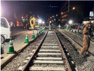
軌条交換工事の様子
