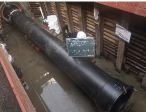
新設した基幹管路
