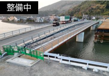
▲橋梁メンテナンス
