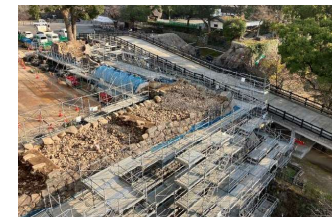
宇土櫓続櫓台石垣復旧(解体)工事(R6.12月時点)
