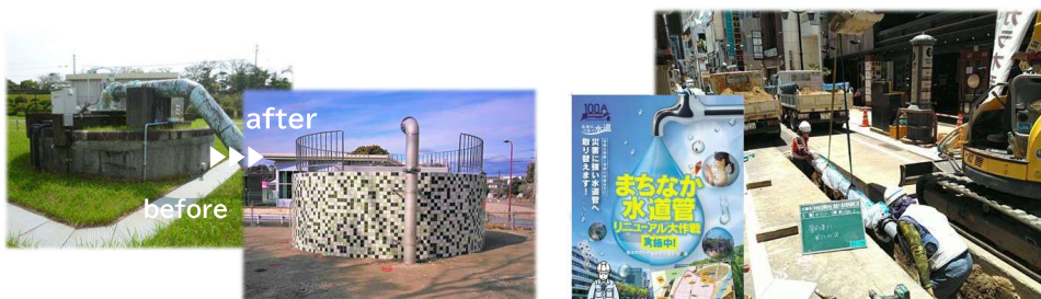
水道施設の更新(健軍水源地集水槽)
