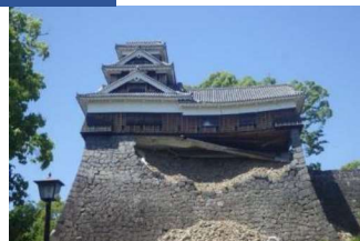
飯田丸五階櫓復旧工事(被災直後の写真)
