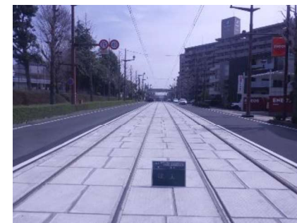
軌条交換竣工後
