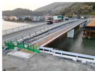
▲橋梁メンテナンス
