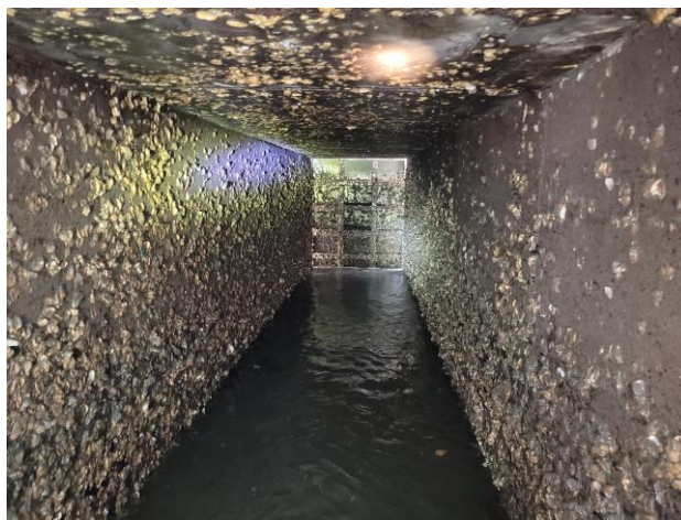
調査状況（管路内面調査）
