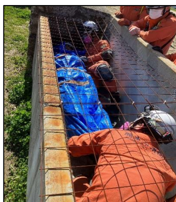
【コンクリート壁破壊（進入路確保）】
