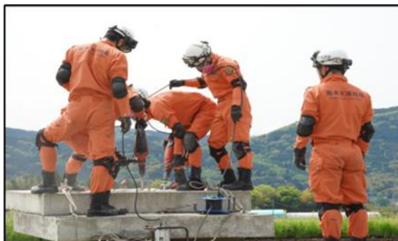
【コンクリート壁破壊（進入路確保）】
