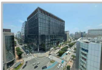
10. 老朽化ビルの連鎖的建替え(天神ビックバン)
