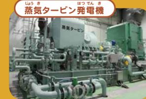
9 ボイラで作った蒸気でタービン発電機を回し電気を作ります。
