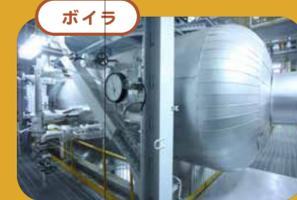
8 焼却炉から発生する排ガスの熱で水を蒸気にかえます。
