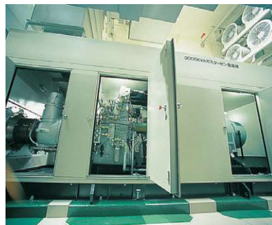
非常用発電設備 停電時、施設に必要な電力を供給します
