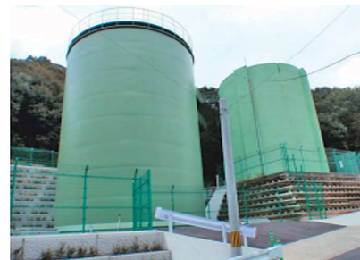
島崎配水池 築造平成22年7月
