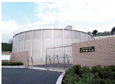
和泉配水池 築造平成18年1月
