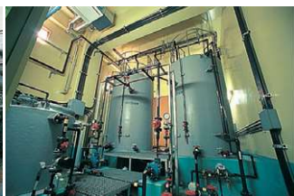
滅菌設備 次亜塩素酸ナトリウムで滅菌します。
