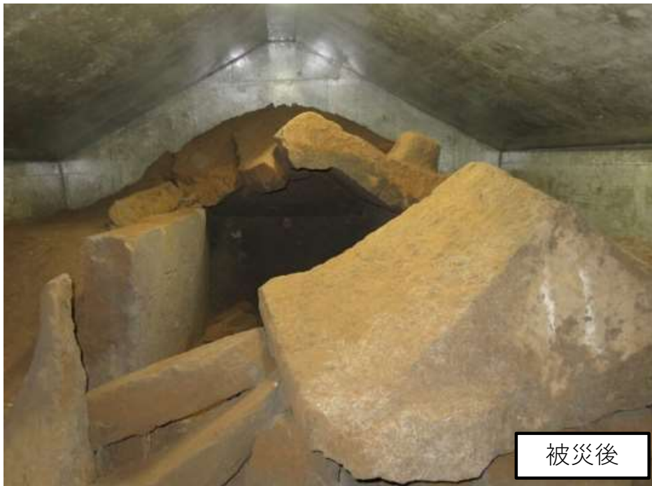
石之室古墳 石棺被災状況
