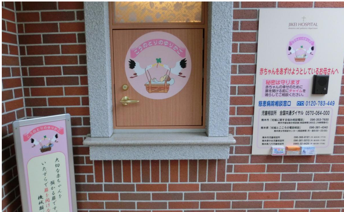
【図 1-1： ゆりかごの外観 平成 26 年 5 月 20 日撮影】
