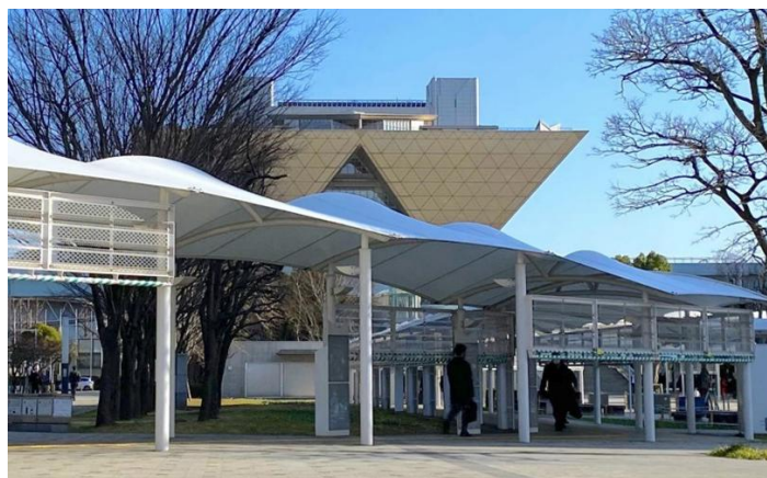
東京ビッグサイトの屋根付き歩道
