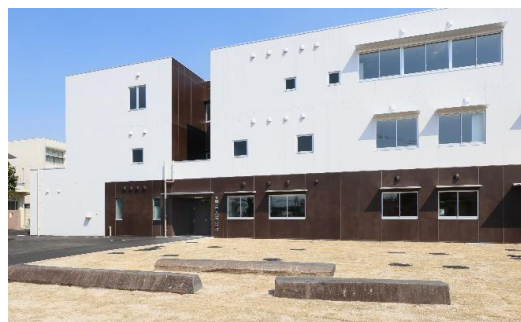
雨水貯留槽 (熊本市立富合小学校)
