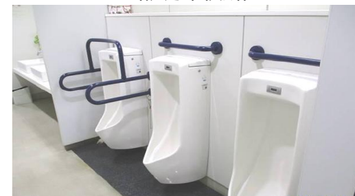
要望により小便器の上部に手摺を設置 (東区役所)
