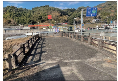
石橋上の舗装 （南東より）
