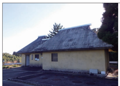
トイレ (北東より)
