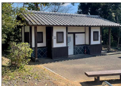
トイレ (北西より)
