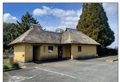
トイレ (南東より)
