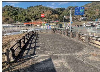
石橋上の舗装 （南東より）
