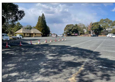
駐車場 (南東より)
