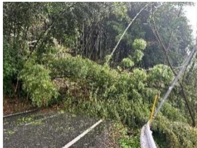
土砂崩れ（北区徳王）
