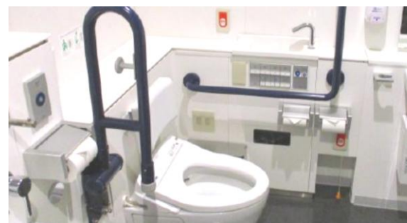
施工段階での意見を元に 肘が当たらないよう手摺位置を調整 (熊本城ホール)
