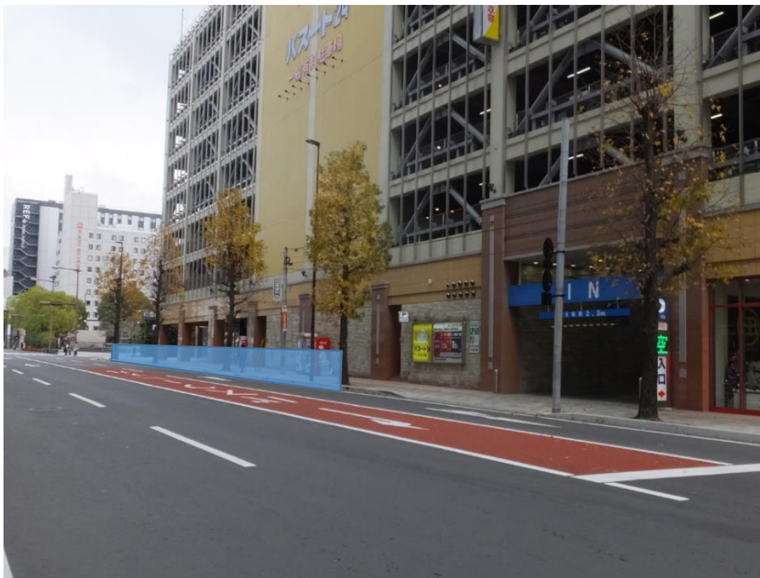
No.4 「市道 辛島町第1号線」熊本市中央区辛島町2番1号先
