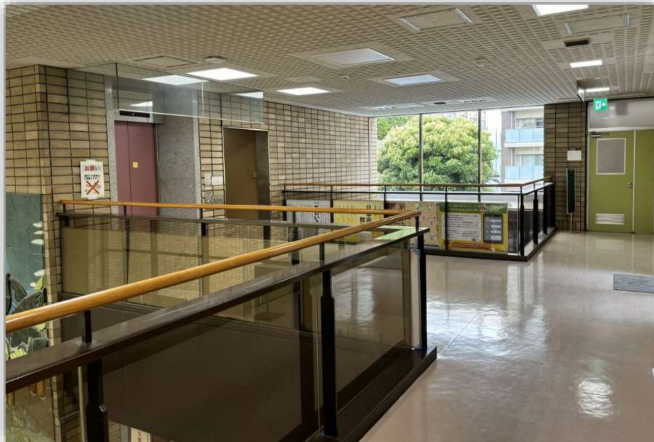
2階にも、安心して通れるように手すりをつくっています。
