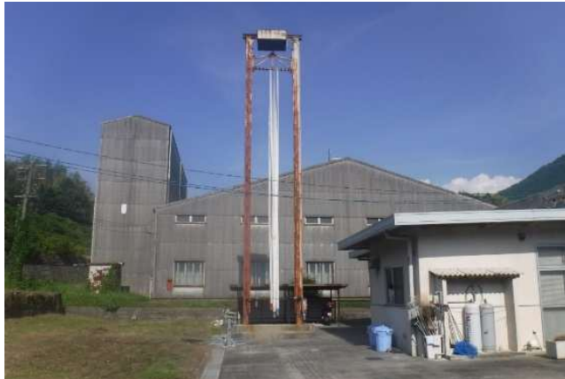
ホース乾燥塔：設置場所の見直し
