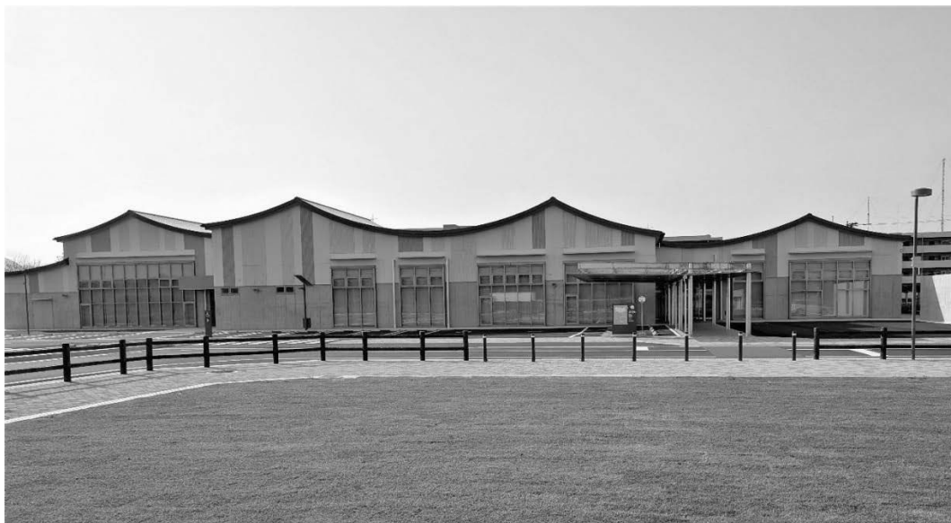
益城町地域共生センター「カタル」（令和7年4月開所）
