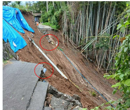
道路崩落による 下水道管路の破損 (北区徳王)
