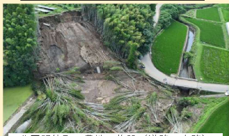
北区明徳町 農地、施設(道路・水路) 土砂流入N=1箇所
