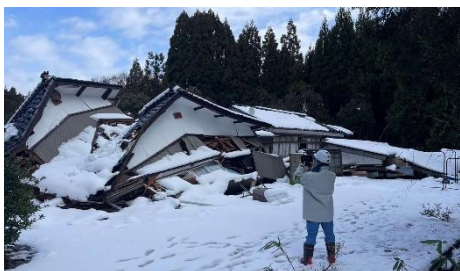
▲ 住家被害認定調査の様子
