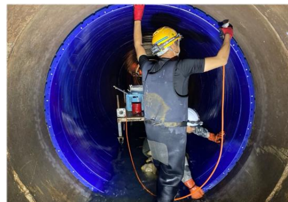
▲ 下水道管耐震化工事の様子
