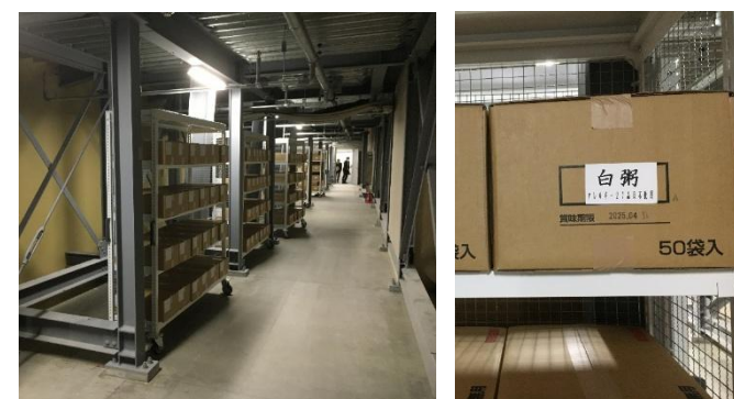
▲ 熊本城ホール 備蓄倉庫
