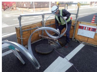
製 管（プロファイル送り）
