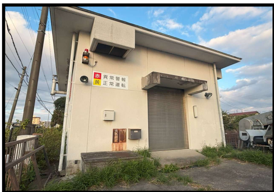
▲パトランプ標識設置完了
