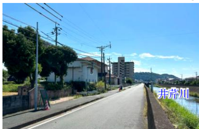
写真 4-2 山ノ下排水機場施設外観②
