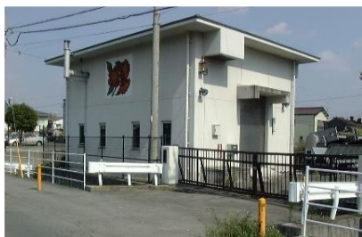
写真 4-1 山ノ下排水機場施設外観①
