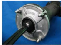
ケーブル壁貫通部の止水処理
