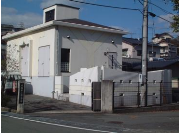
中継ポンプ場（花園第二ポンプ場）
