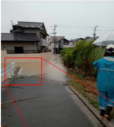
11日7時頃の状況 (ポンプ場東側道路)
