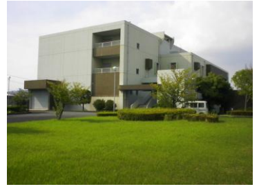
中継ポンプ場（平田ポンプ場）
