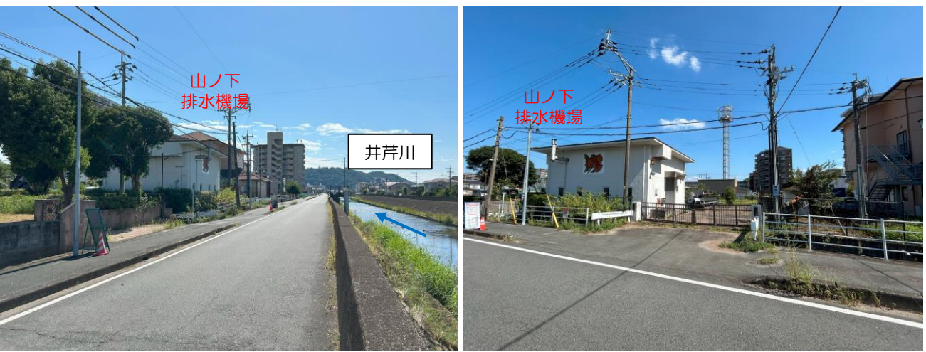
山ノ下排水機場
