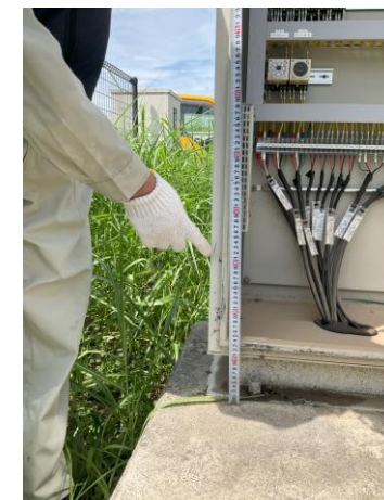
② 高圧受電盤 浸水状況
