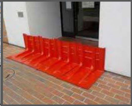
▲止水板の設置状況
