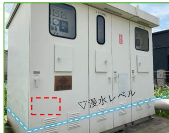
① 高圧受電盤 浸水状況（屋外）
