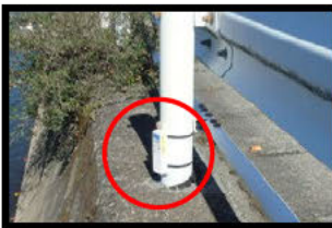
▲ワンコイン浸水センサの設置事例
