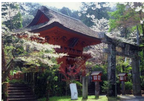
六殿神社楼門全景
