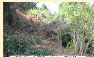
西区河内町船津 農地(樹園地) 法面崩壊L=16.0m
