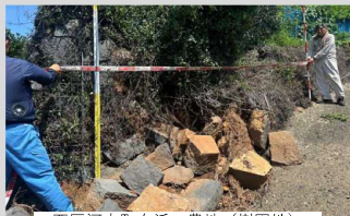
西区河内町白浜 農地(樹園地) 石垣崩壊L=4.3m
