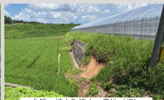
北区、植木町清水 農地(畑) 法面崩壊L=7.0m
