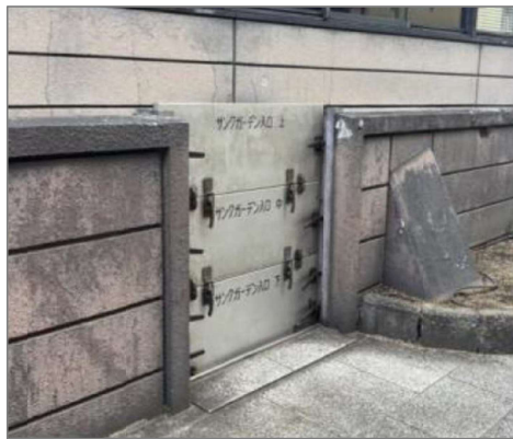
建具タイプ (地下進入口等に施工)
