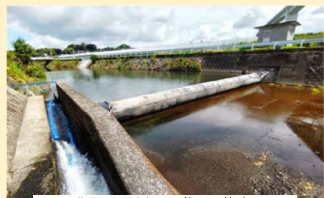
北区下硯川町 施設(堰) 頭首工復旧N=1箇所
