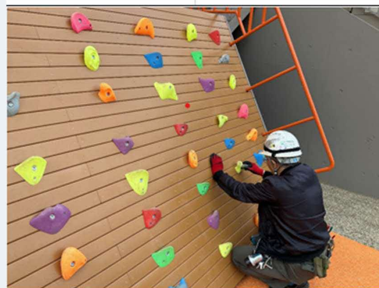
点検時に増し締め作業
