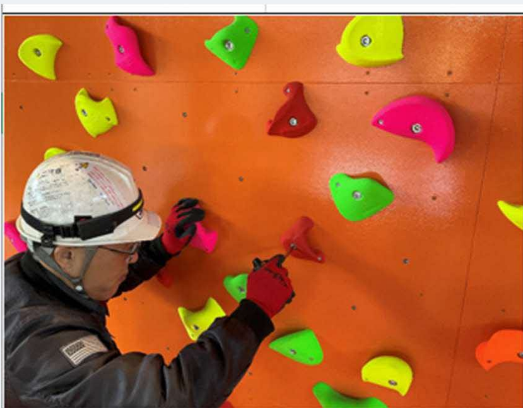
点検時に増し締め作業
