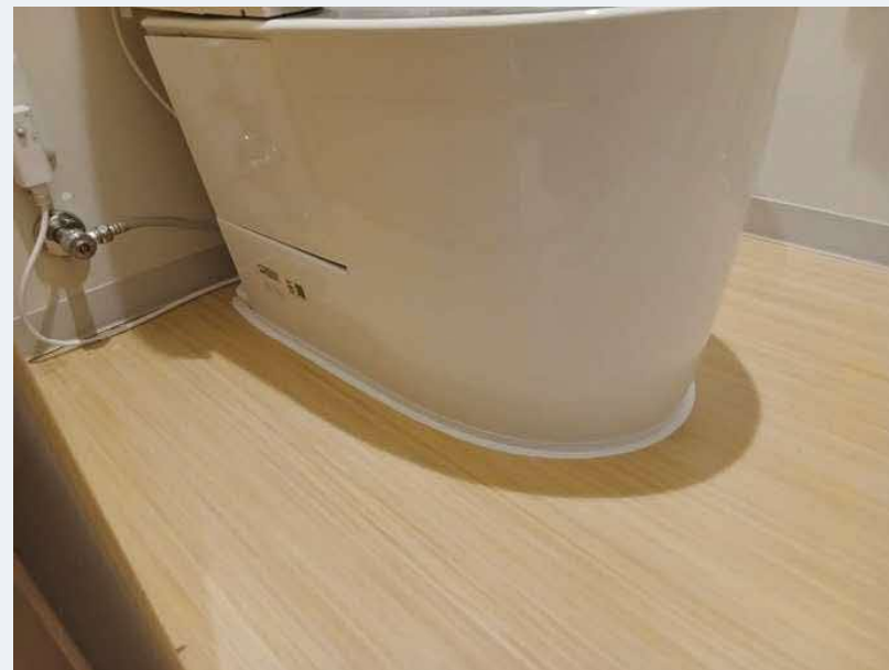
清掃実施後、隙間テープ埋め
