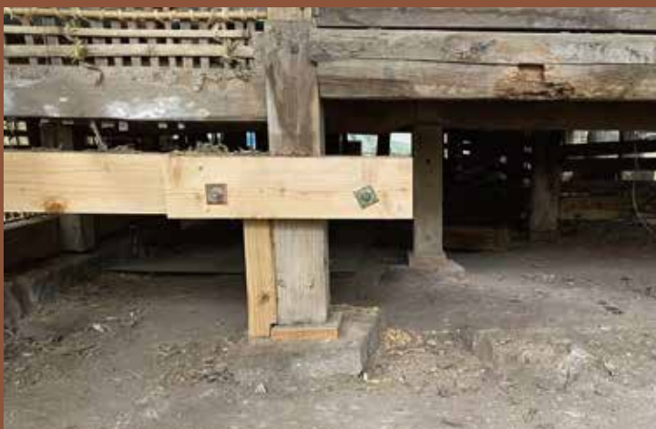
礎石と柱の間に「支物」を入れた。
