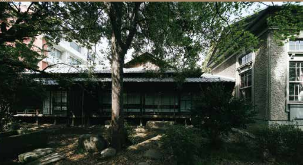
庭から見た旧居。増築を繰り返しており、中央部分が明治時代の建物だ。
