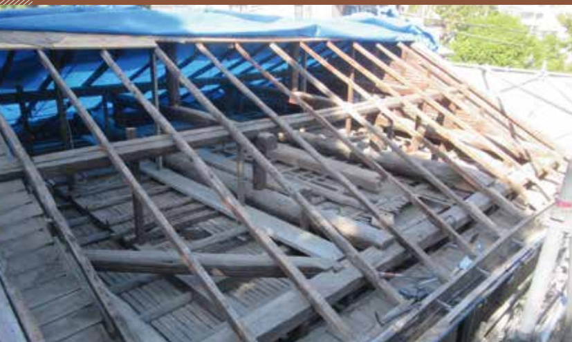
洋館の屋根部分。複雑な組み立て方がしてある。
