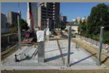
鉄骨を入れて耐震補強をした。
