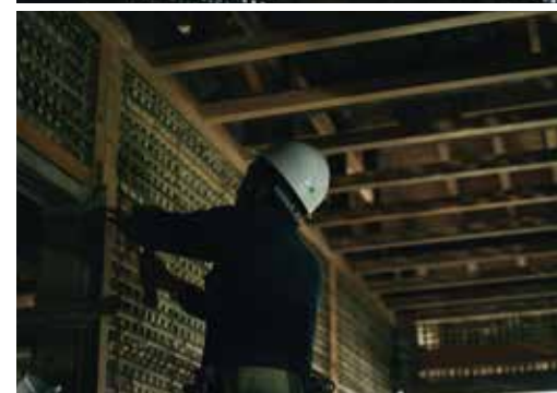
外観は洋館だが、壁は竹を編んで土壁を塗る在来の工法で造られていた。復旧も在来工法で行われた。
