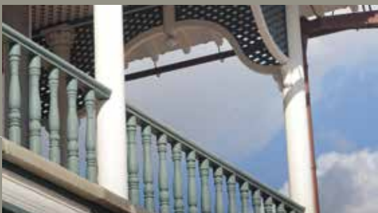
手すりを支える「手すり子」はくびれの位置や数が少しずつ違い、手作業だと分かる。
