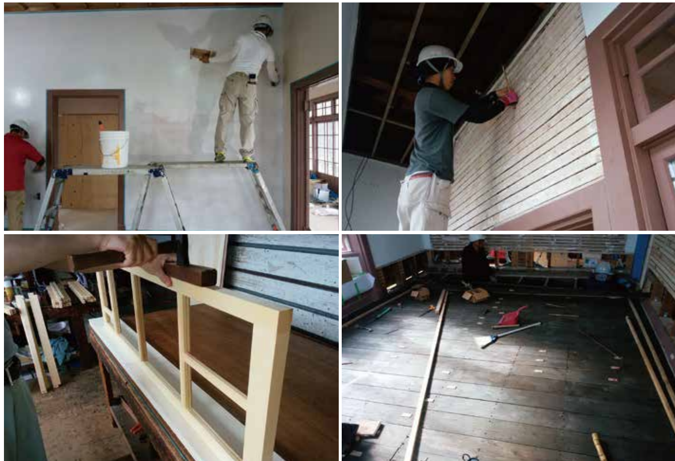
白アリの被害を受けた箇所は、食われた部分を切って新しい木材を当て込んだ。1階の床板の復旧にあたっては、板の位置を記録し、すべての床板を元の位置に正確に戻した。
