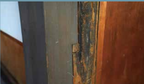
古い柱(右側)を削り、合う形にした新しい柱(左側)と組み合わせた。
