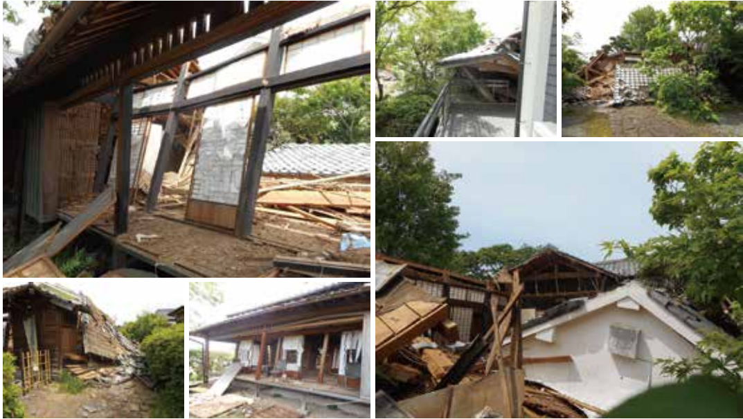
本震で倒壊した四時軒。書斎のある広間や玄関など、1982(昭和57)年に建設された建物は全壊した。
